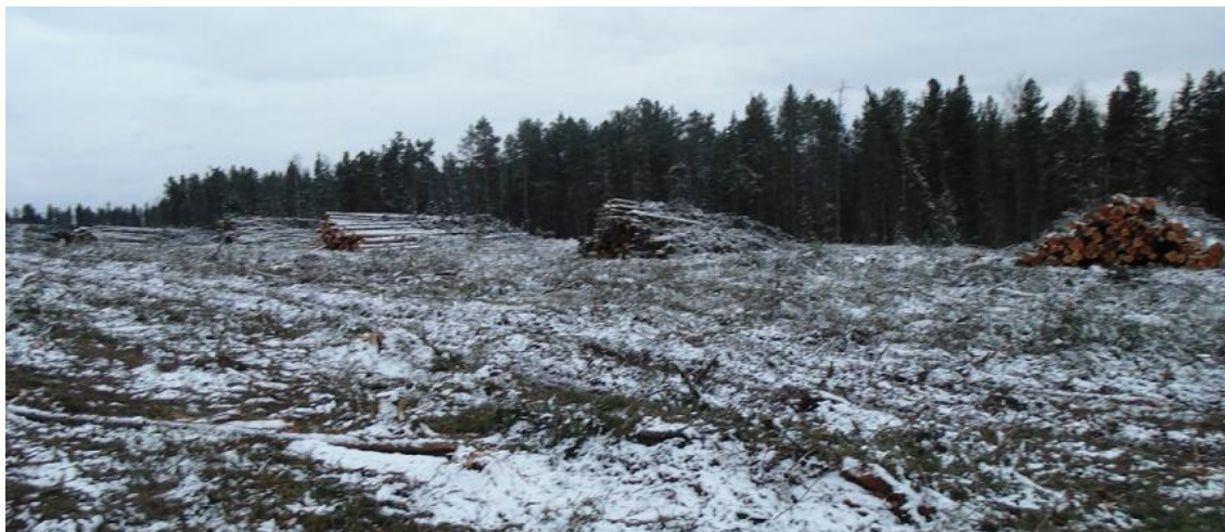
Рис. 4. Укладка пакетов деревьев перпендикулярно продольной оси линейного объекта
