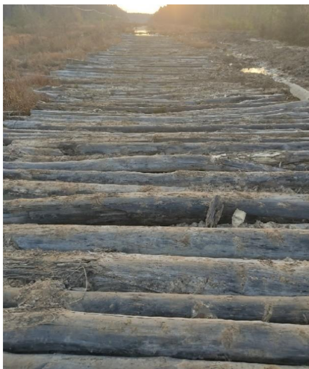
Рис. 2. Лежневый настил проезда для грузового транспорта по середине трассы линейного объекта
