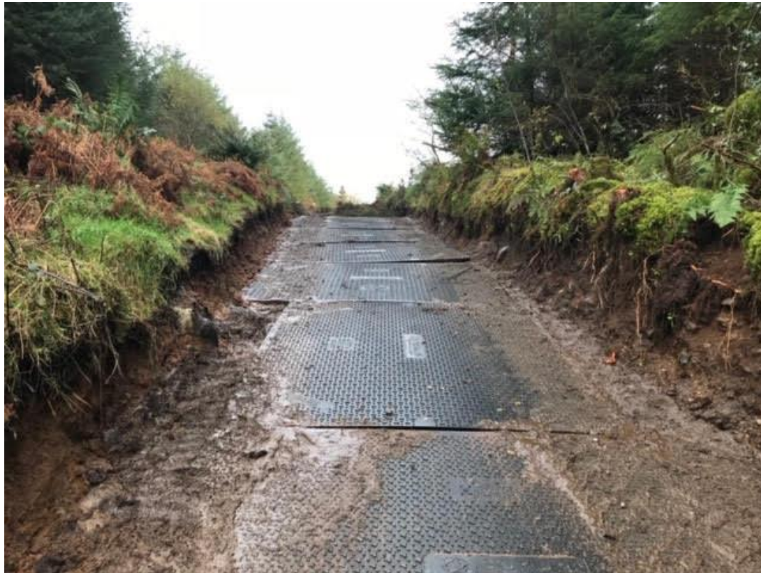
Рис. 3. Настил из пластиковых сборно-разборных дорожных покрытий
