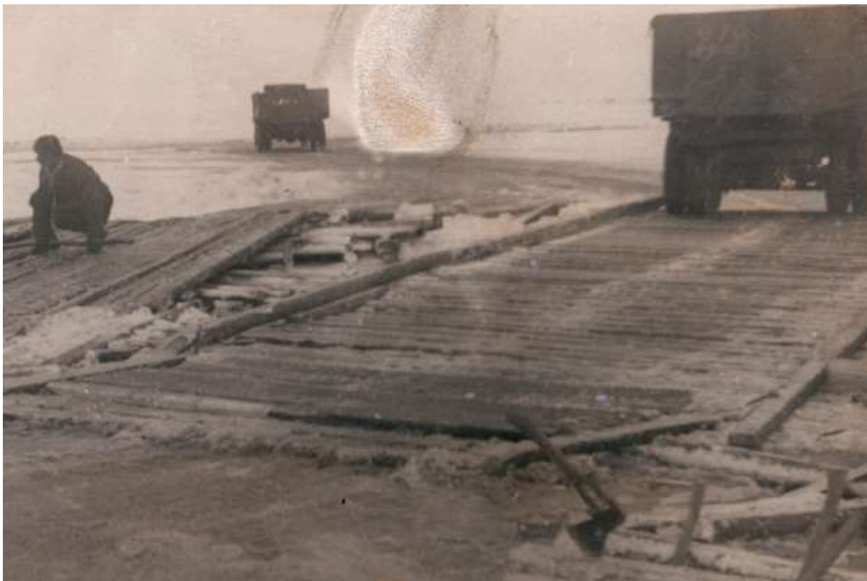
Рис.1. Переправа на Дороге жизни
