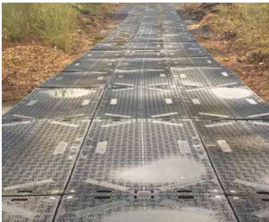
Рис.6. Временный транспортный путь из пластиковых матов
