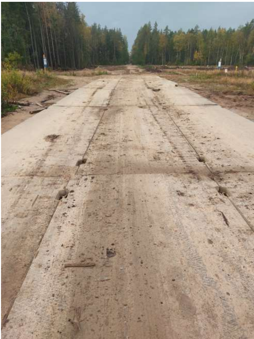
Рис.4. Дорога с покрытием из железобетонных плит
