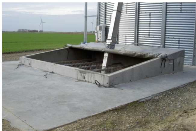
Фото 3. Завальная яма (утопленного исполнения), установленная перед металлическим хранилищем (Дания).
